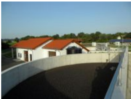
Eindicker mit Maschinenhaus
